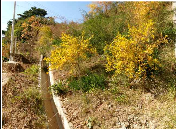
상부 성토부 전경
