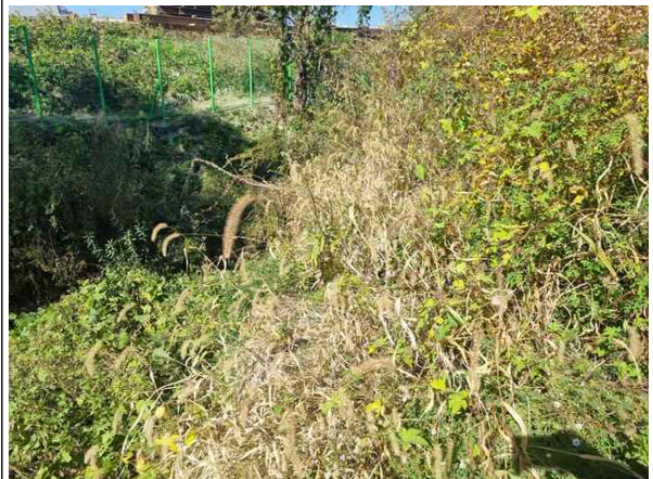
상부 성토부 전경
