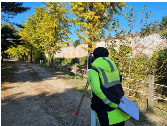
광파기를 이용한 측량 작업
