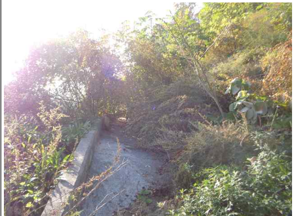
상부 절토부 전경
