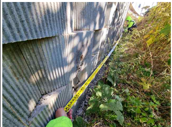
스토퍼를 이용한 구간분할 측정
