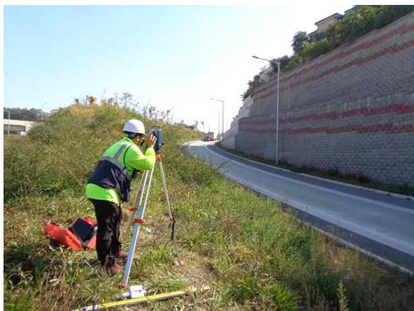
광파기를 이용한 측량 작업
