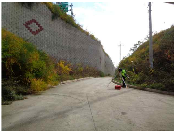
광파기를 이용한 측량 작업
