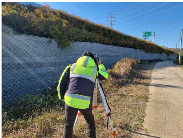
광파기를 이용한 측량 작업
