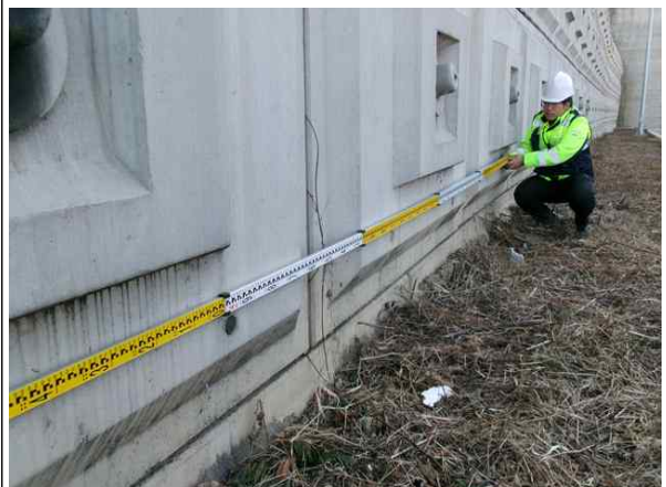
스토퍼를 이용한 구간분할 측정
