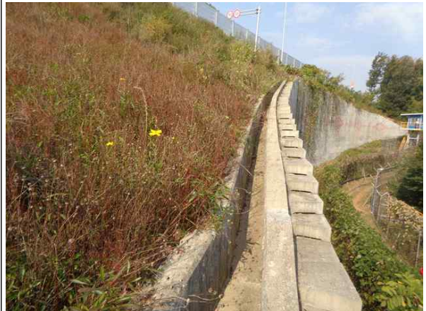
상부 성토부 전경
