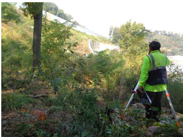
광파기를 이용한 측량 작업
