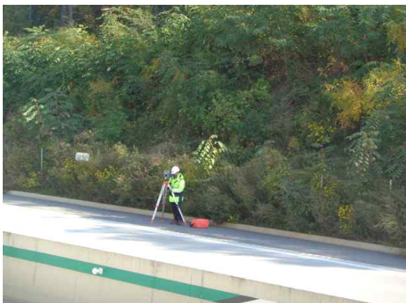
광파기를 이용한 측량 작업
