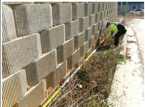
스토퍼를 이용한 구간분할 측정
