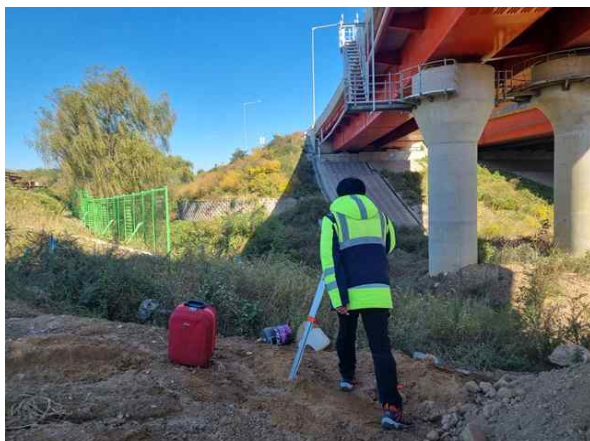
광파기를 이용한 측량 작업
