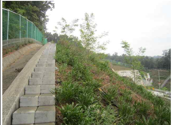
상부 절토부 전경
