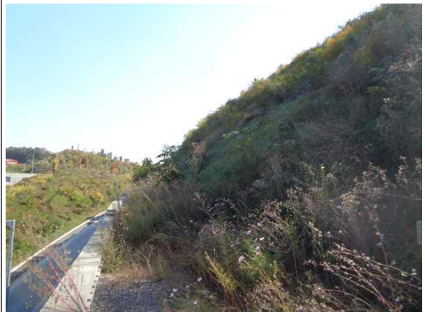
상부 절토부 전경
