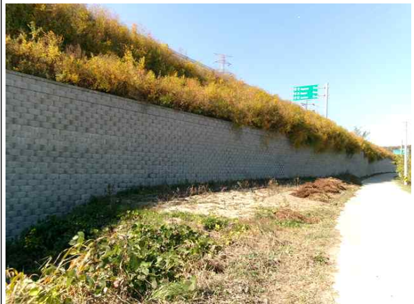
상부 성토부 전경
