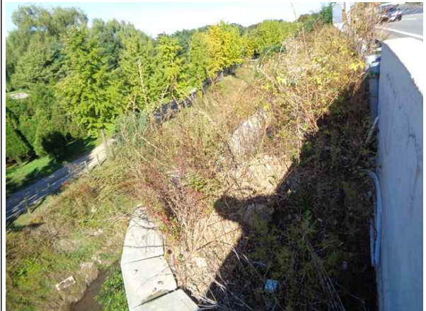
상부 성토부 전경
